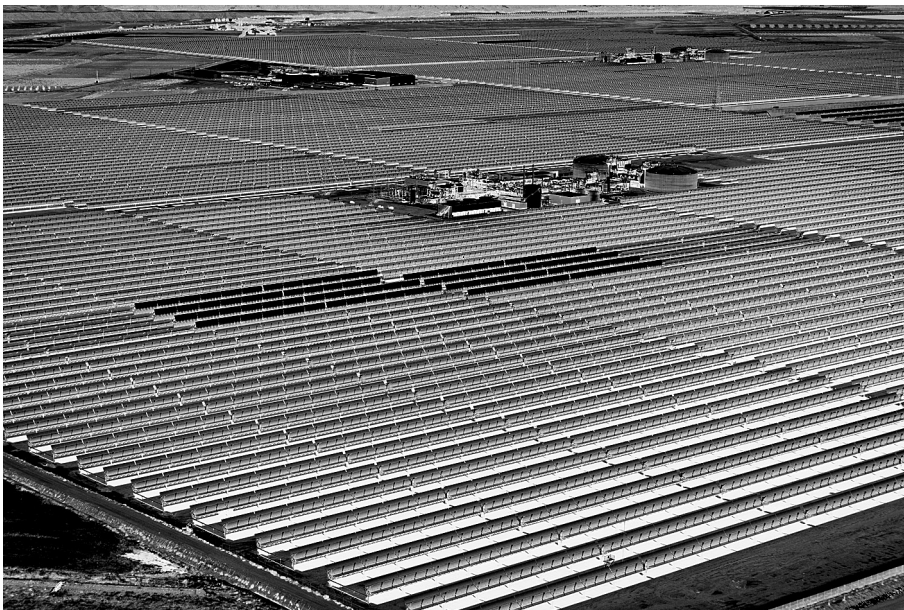
081 Die gewaltige mit Parabolspiegeln bestückte Fläche der Kraftwerkanlage Andasol
